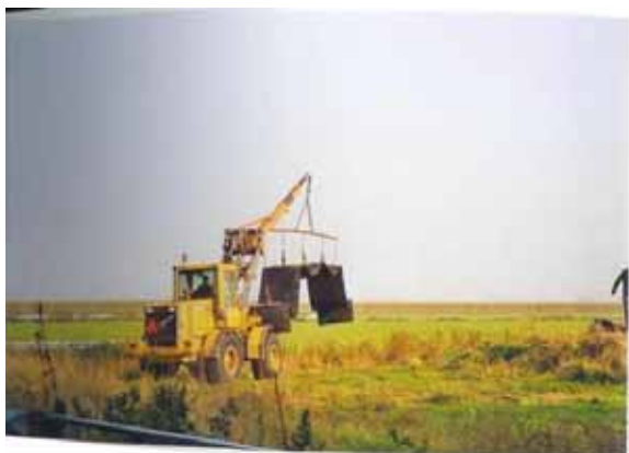
Grote rubberen matten worden aan een speciaal frame met een shovel over de kuil gelegd
