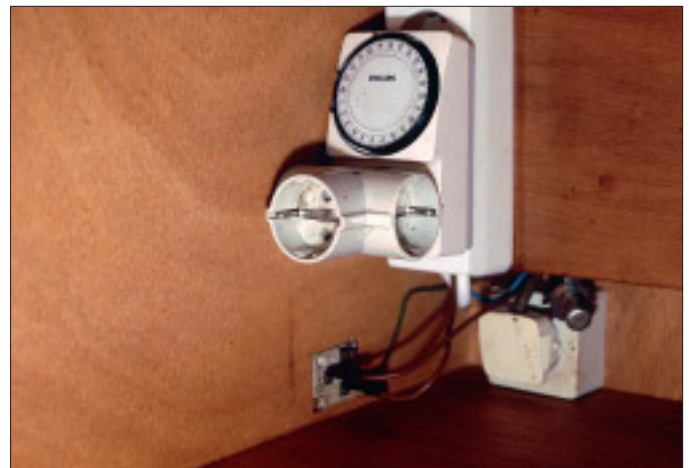
V.l.n.r. voeler van de staafthermometer – voeler thermostaat – wandcontactdoos voor kachel en grote wandcontactdoos met tijdklok
