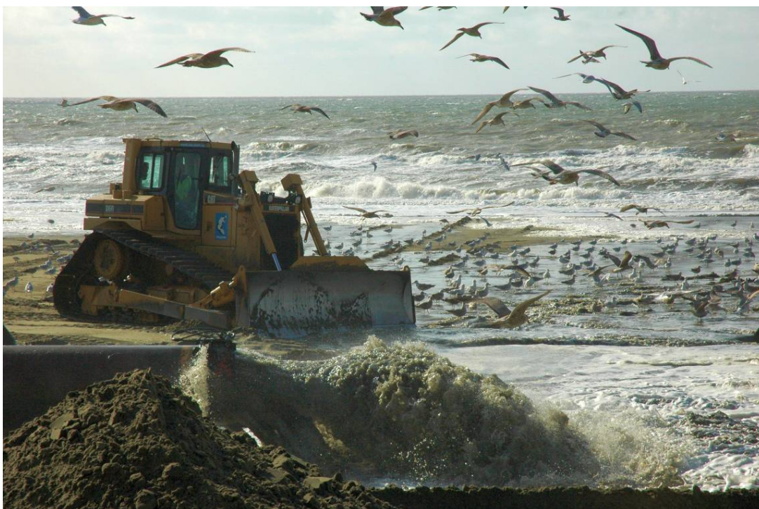
Figuur 8. Bij een strandsuppletie wordt met bulldozers het opgespoten zand over het strand verdeeld (Foto: Martin Baptist, IMARES).
