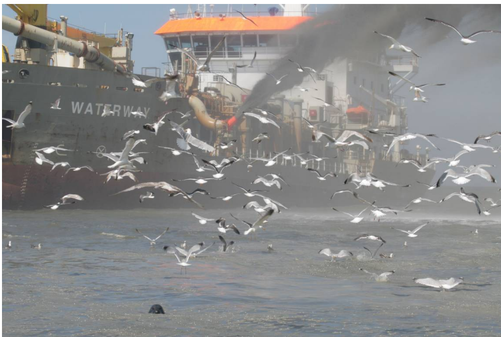
Figuur 9. Bij een vooroeversuppletie wordt het zand vaak door middel van 'rainbowen' aangebracht. De dode bodemfauna en vissen van de zeebodem trekken meeuwen en zeehonden aan (Foto: Hans Verdaat, IMARES).
