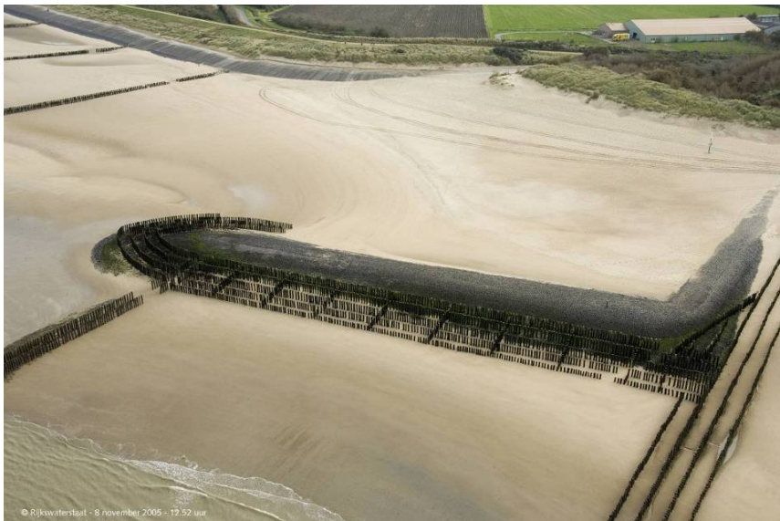
Figuur 3. Kruishoofd bij Nieuwvliet Bad, Zeeuws-Vlaanderen, is een oud dijklichaam en een voorbeeld van een combinatie van steen en hout als kustverdediging (Bron: Rijkswaterstaat, www.kustfoto.nl )
