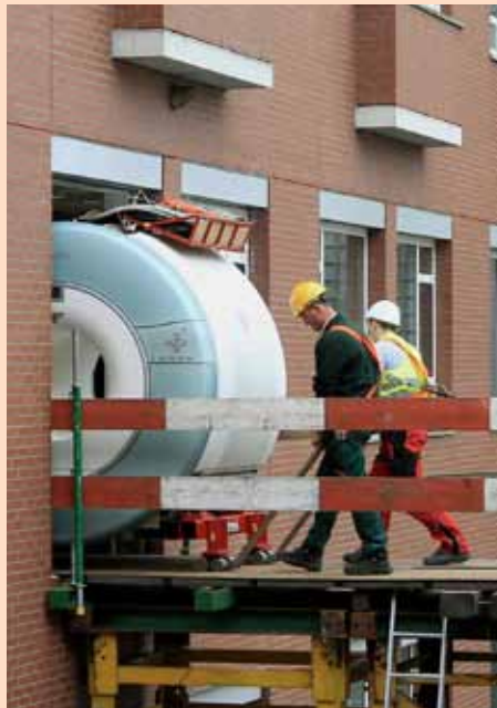
De magneet voor een nieuwe MRI-scanner wordt Ziekenhuis Gelderse Vallei ingereden.
