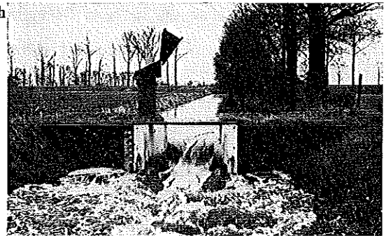
Fig. 6.11. Enige stuwtypen waarmee in het Leerinkbeekgebied de afvoer is gemeten. a. Thomson meetschot 90° (meetpunt 2); b. Bodem en taludverdediging met nijlondoeck (meetpunt 11); c. Bestaande stuw die na ijking als meetstuw is gebruikt (meetpunt 6); d. Samengesteld Thomson/Cipolletti meetschot (meetpunt 3); e. Transport van een H-flume; f. H-flume met max. capaciteit van 2,2 m 3 /sec (meetpunt 13); g. Het plaatsen van een Parshall flume (meetpunt 10); h. Parshall flume met max. capaciteit van 2,3 m 3 /sec (meetpunt 10) Some types of structures where in the Leerinkbeek area the discharge has been measured. a. 90° V-notch sharp-crested weir (gauging site 2); b. Lining of nylon to resist erosion (gauging site 11); c. Existing weir which after calibration has been used for discharge measurements (gauging site 6); d. Compound V-notch/Cipolletti weir (gauging site 3); e. Transport of an H-flume; f. H-flume with a max. capacity of 2.2 m 3 /sec (gauging site 13); g. Installation of a Parshall flume (gauging site 10); h. Parshall flume with a max. capacity of 2.3 m 3 /sec (gauging site 10)
