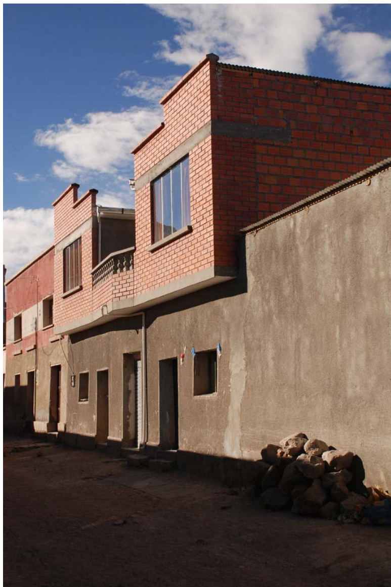
Foto 36. Mejoramiento de vivienda: ladrillo y cemento sobre adobe y barro, Salinas de Garcí Mendoza (fuente: el autor)
