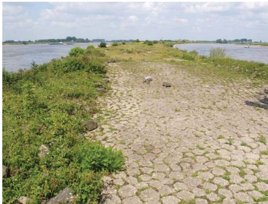
De belangrijkste dam van Nederland, de hoofddam van Pannerden. Verzonken in de dam, ligt het kolossale fort dat waakte over de ongestoorde watertoevoer naar het hartje van de Nieuwe Hollandse Waterlinie.
