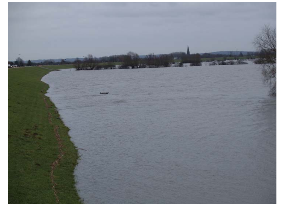
De grote inlaagdijk bij Herwen, die voorkwam dat de Oude Waal doorbrak naar de Oude Rijn. De bouw van de inlaag was de redding van Midden-Nederland. Op de achtergrond de spits van het nieuwe Herwen dat aan de Rijndijk verrees.
