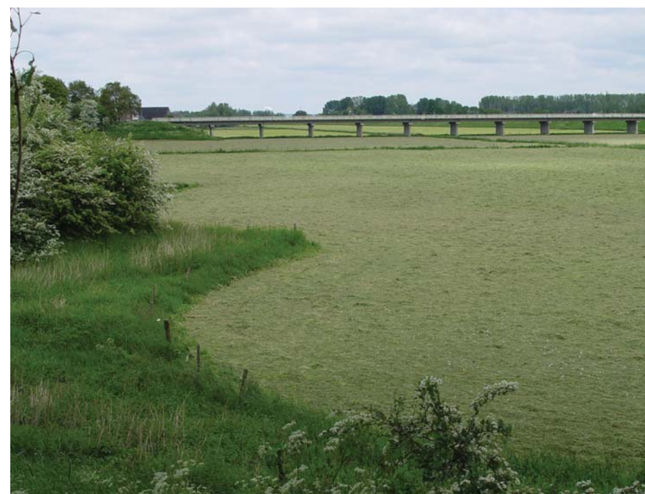
Groene rivier bij Pannerden, aangelegd rond 1959 in verband met de sluiting van de Spijkse Overlaat. Voor de aanleg van de groene rivier moest een deel van Pannerden worden opgeofferd.
