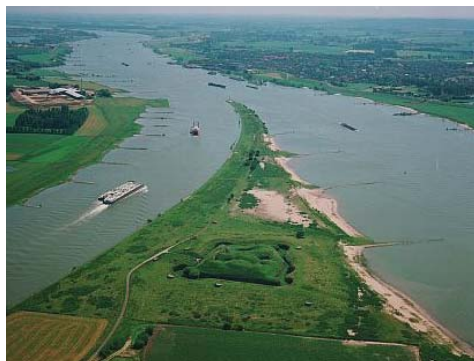
De landtong tussen Waal en Pannerdensch Kanaal met het formidabele fort Pannerden, het slot op de hoofdkraan van de Nieuwe Hollandse waterlinie. Bron: http://www.hollandsewaterlinie.nl/items/fort-pannerden.aspx
