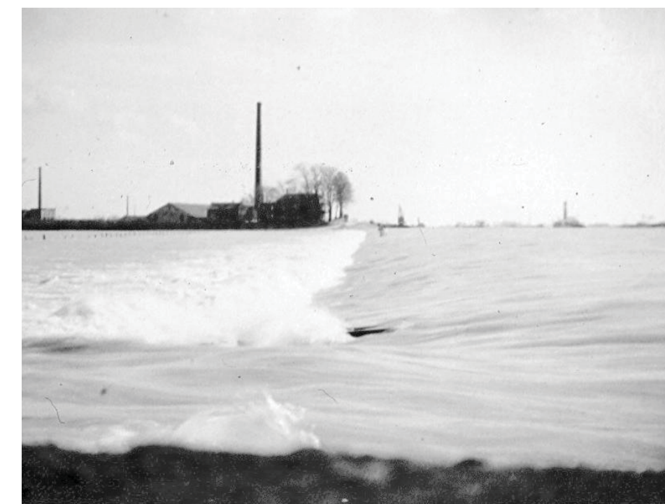
Met kracht stroomt het Rijnwater over de drempel van de Spijkse Overlaat. Door de werking hiervan liep het water ook richting Emmerik. Bron: Collectie Ben Janssen
