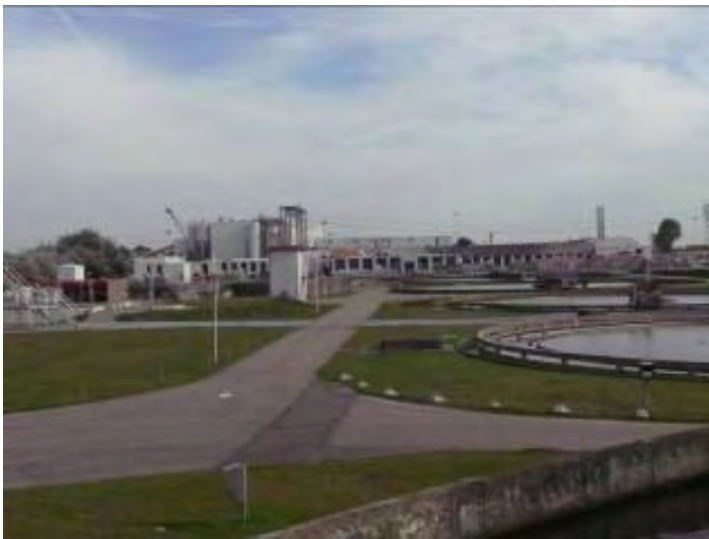
Figuur 6.1 Locatie 1A: Vijzelturbine naast het leidingtracé nieuwe AT – oude AT
