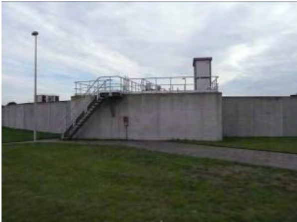
Figuur 4.1 Aanzicht verdeelwerk aan aëratietank 1
