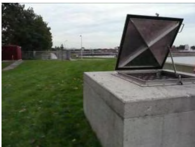
Figuur 4.10 Verzamelput hooggelegen NBT's richting effluentsloot
