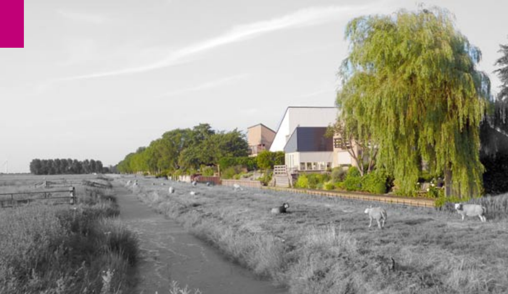
Fig. 5.37 en 5.38 De stad-landovergang [4-NWZ] is opgebouwd uit vrijstaande woningen die met de percelen direct aan het open veenweidelandschap gesitueerd zijn. Hierdoor is er tussen het landschap en de private woningkavels geen openbare groenstructuur mogelijk. Het opgaande groen wat zichtbaar is vanuit het landschap, wordt gevormd door privaat groen van solitaire bomen. Op de achtergrond zijn de toppen van een bomenlaan langs een ontsluitingsweg zichtbaar (onder).
