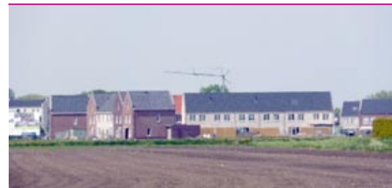
Fig. 6.26 De zuidelijke eilanden in aanbouw (mei 2011). Hoe verstedelijkt zal de nieuwe stad-landovergang van Bunschoten worden in dit nationaal landschap Arkemheen-Eemland?
