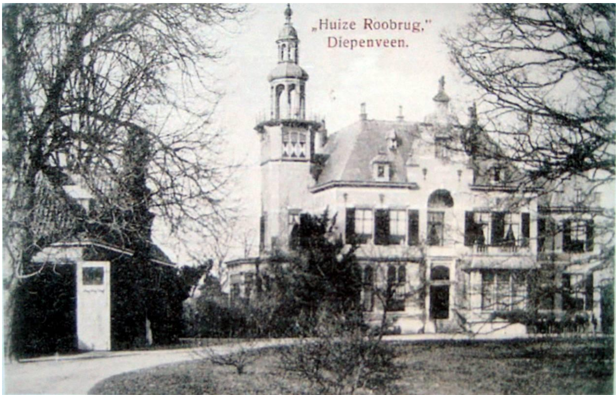
foto omstreeks 1925 Roobrug, neo-renaissance hoofdhuis gebouwd ca. 1898
