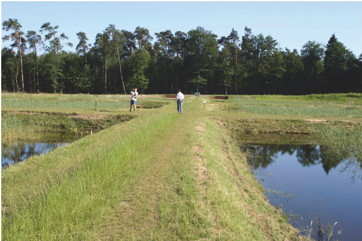
Oude Vloeisystemen op landgoed Het Lankheet bij Haaksbergen worden gebruikt voor waterretentie en waterzuivering.
