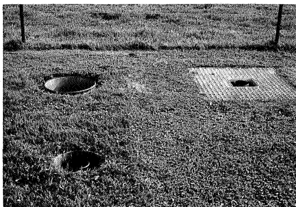
Figuur 4 Verschillende typen grondregenmeters opgesteld op maaiveldniveau op station Hupsel; linksboven de Recover
