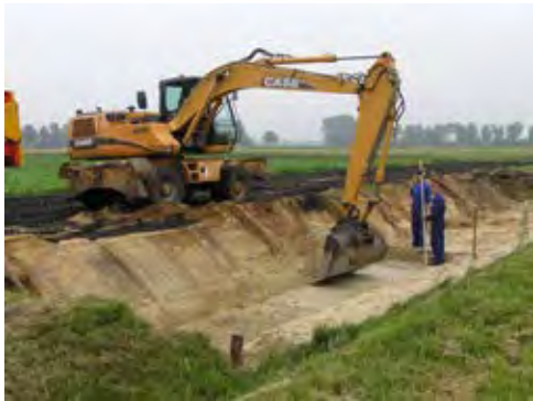
Aanleg beekbegeleidend vloeiveld zomer 2006
