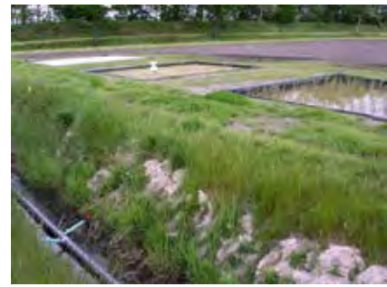
Drains en zuiveringsmoerassen
