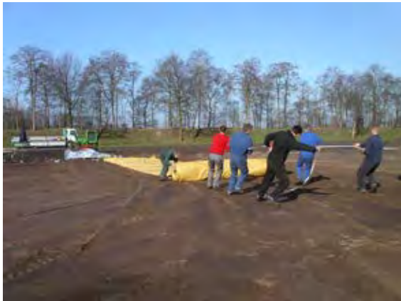
Aanleg waterzak (maart 2005)
