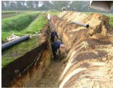
Aanleg bypassbuis langs referentiesloot
