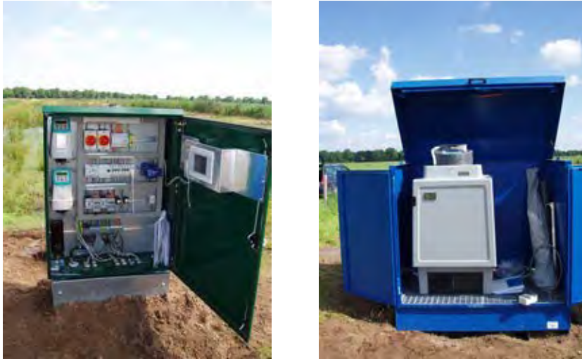
Figuur 4.4. Aansturing pompen en Isco debietproportionele sampler
