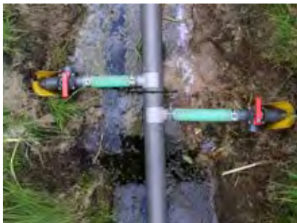
Aansluiting drains op verzameldrain
