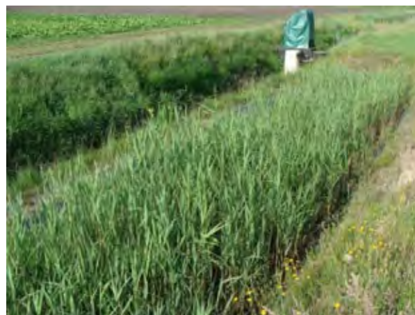
Beekbegeleidend vloeveld voor nitraatverwijdering op PPO-proefbedrijf Vredepeel met links de sloot en achteraan één van de debietproportionele meetunits.
