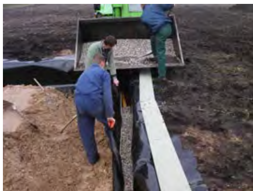
Het vullen van de instroomopening met grind
