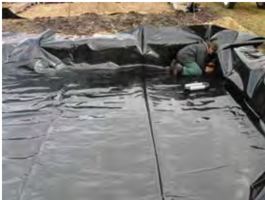
Aanbrengen afdichtingsfolie
