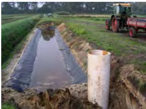
Beekbegeleidend vloeiveld en verzamelput na aanleg
