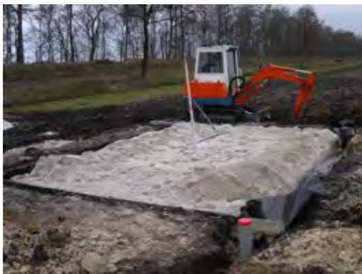
Het vullen van het zuiveringsmoeras met metselzand
