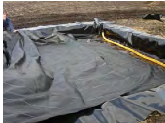
Aanbrengen anti-worteldoek.
