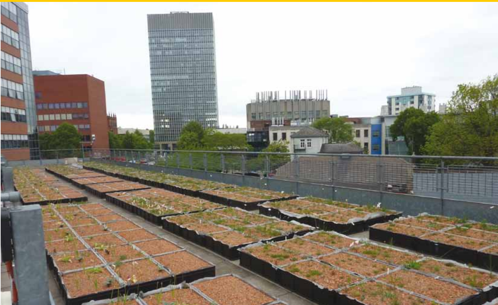
Het plantenonderzoeksdak op het Hicks-gebouw in Sheffield.
