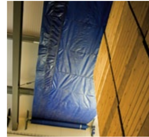
▲ Bij systeem 2 kan het zeil automatisch oprollen.
