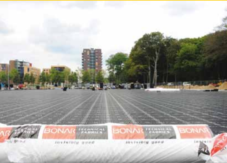
07 Drukverdelend geotextiel wordt uitgerold over de kratjes.
