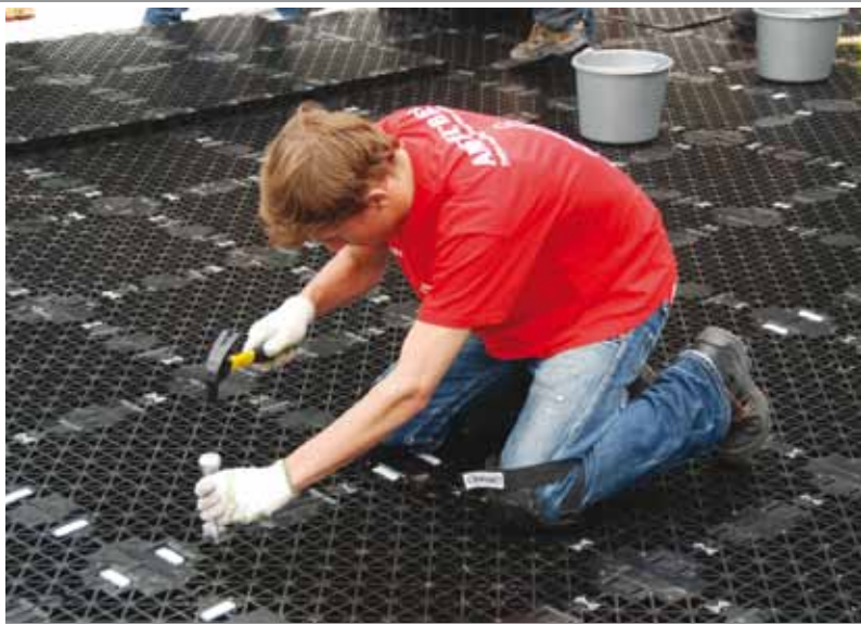
06 Verbindingen tussen de kratjes worden nogmaals handmatig nagelopen.
