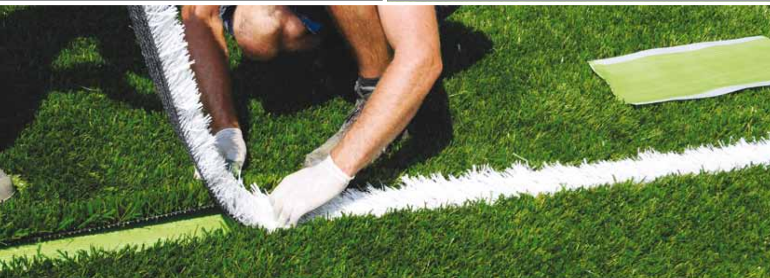
14 Alle naden zijn genaaid, behalve de belijning.
