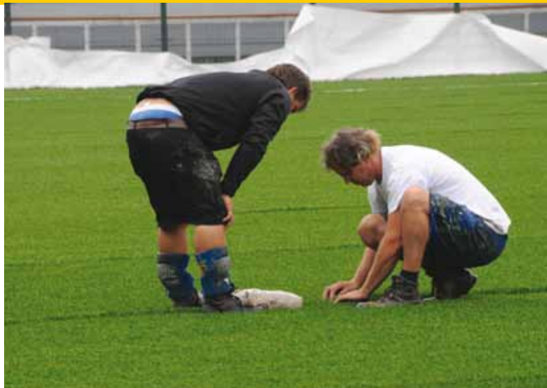
13 Controleren naden.
