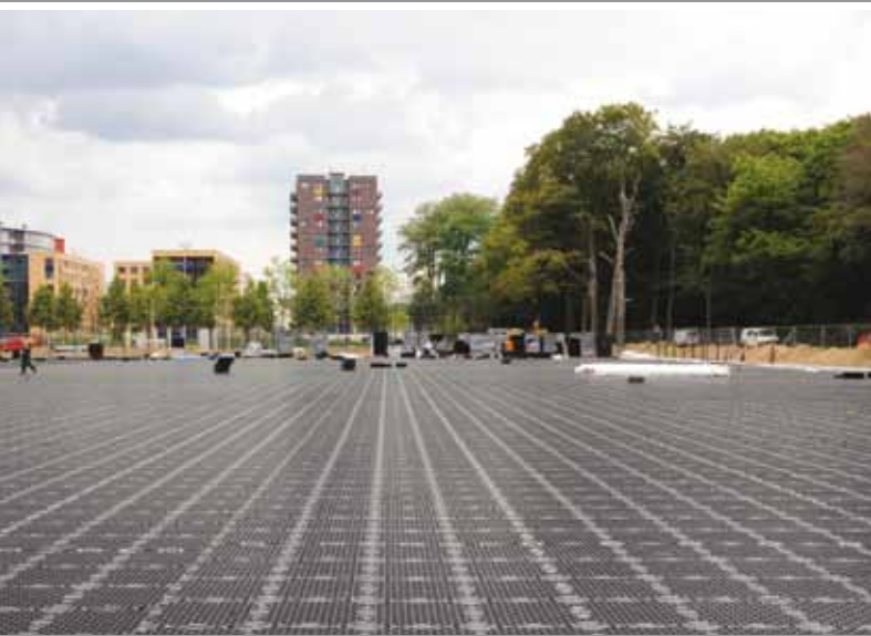
05 Alle kratten zijn geïnstalleerd.
