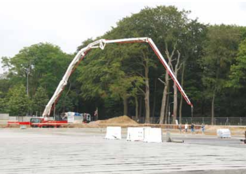
02 Laatste deel van het betondek op de parkeerkelder wordt opgebracht.
