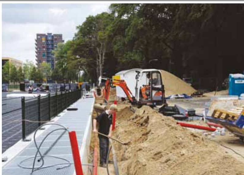
16 Werk rondom het veld: aanbrengen beregeningsbuizen.
