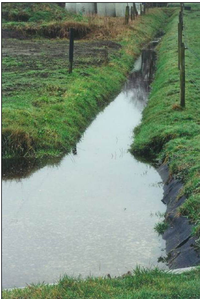
Afbeelding 5.7: Door de afvoer van het erfwater via het grindfilter is er zelfs bij veel neerslag geen wateroverlast meer rond de afvoersloot. Dit water (met daarin nutriënten) wordt nu benut in de drogere delen van het perceel
