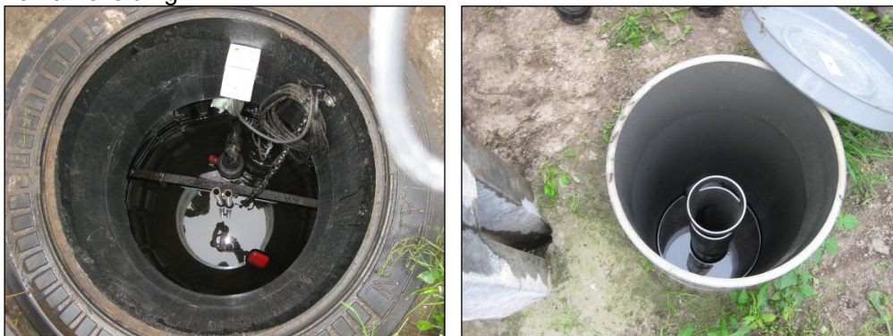
Afbeelding 2: Bedrijfsbezoek M Goorden: Drainage systeem met pompput (links) en peilgestuurde infiltratie (rechts)
