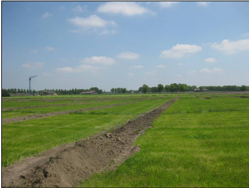
Afbeelding 3.8: Ligging drainagedrains op het perceel van dhr. M. Goorden
