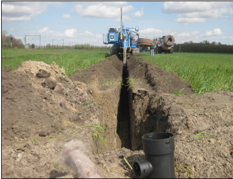
Afbeelding 3.3: Aanleg drains op het perceel van dhr. J. Denissen
