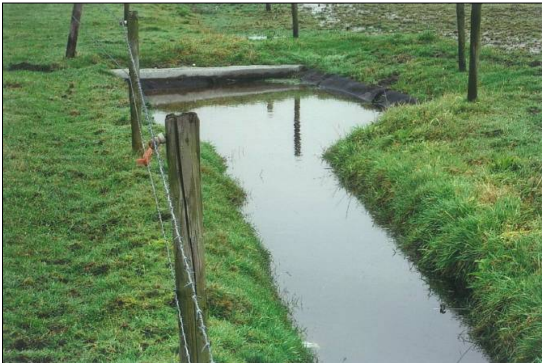
Afbeelding 5.1: Grindfilter na grote hoeveelheid neerslag
