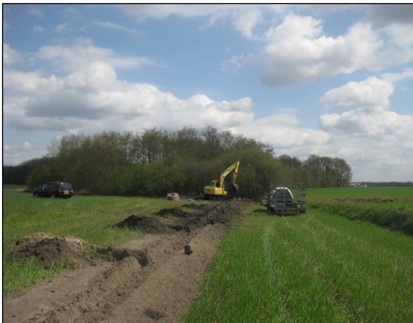
Afbeelding 3.4: Aanleg hoofddrain richting pompput op het perceel dhr. J. Denissen
