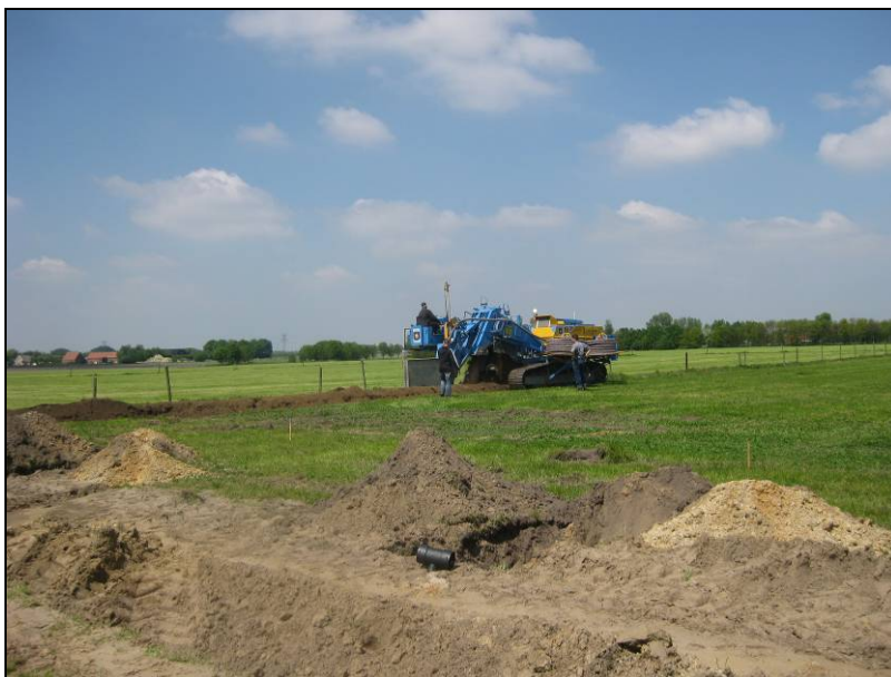
Afbeelding 3.9: Aanleg infiltratiedrains op het perceel van dhr. M. Goorden
