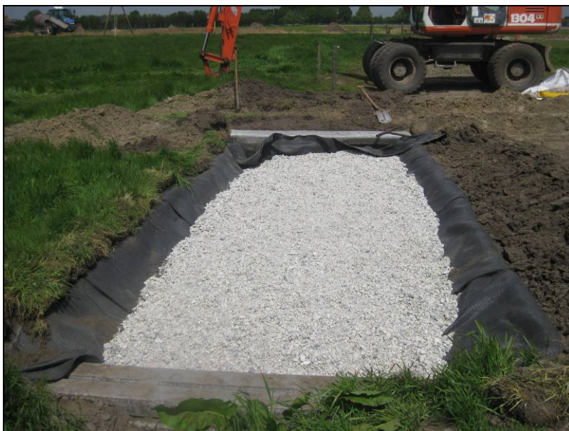
Afbeelding 3.10: Grindfilter voor zuivering van het afstromend erfwater van dhr. M. Goorden
