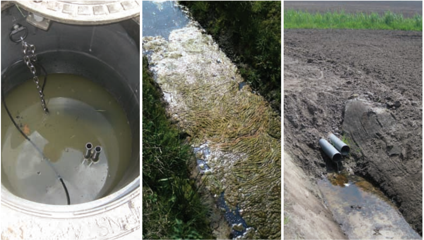
Foto's van links naar rechts: de pompput, draadwieren zorgen voor opname nutriënten en uitstroom pomp
