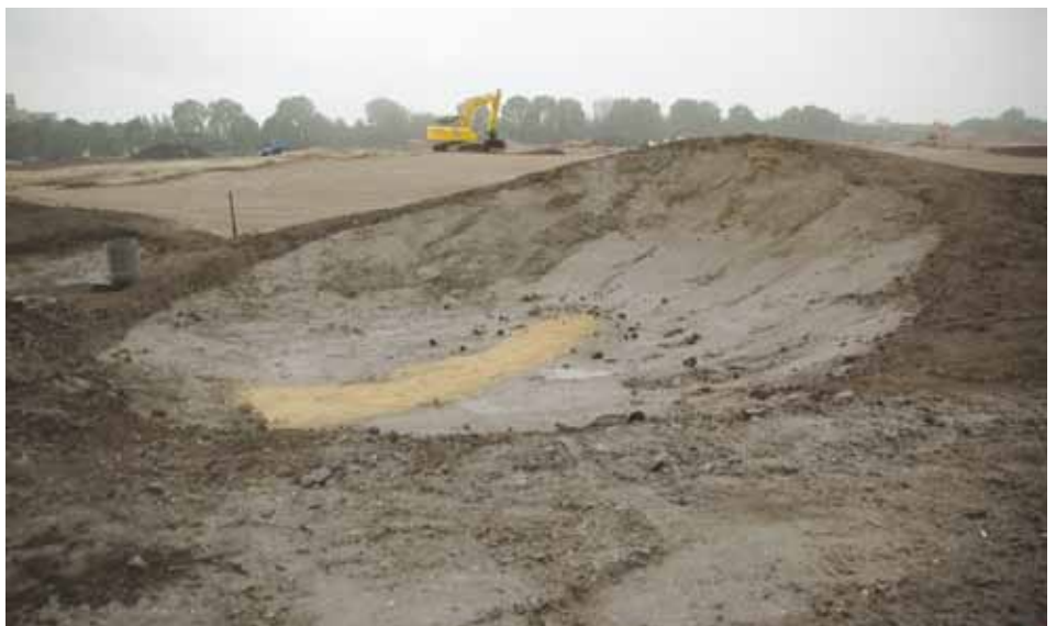
Er worden verschillende bunkertypes aangelegd.
