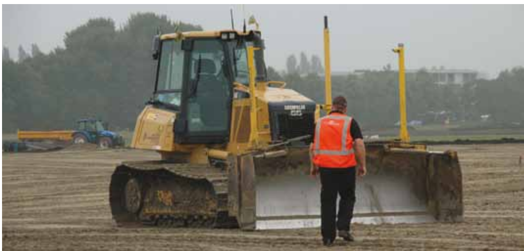
De aannemer werkte vrijwel uitsluitend met graafmachines. In slechts één situatie zette Heijmans Sport en Groen een lichte bulldozer in. Vanwege eventueel ondergrondbederf mocht deze maximaal driemaal over hetzelfde spoor rijden.
