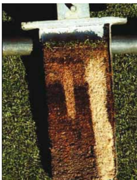
Een gelaagd profiel vormt een beperking voor de drainage.
