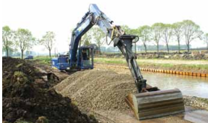
◀ De ballast voor de zinkstukken wordt per truck aangevoerd uit Utrecht. Alles direct op afroep, om tussenopslag te voorkomen.
