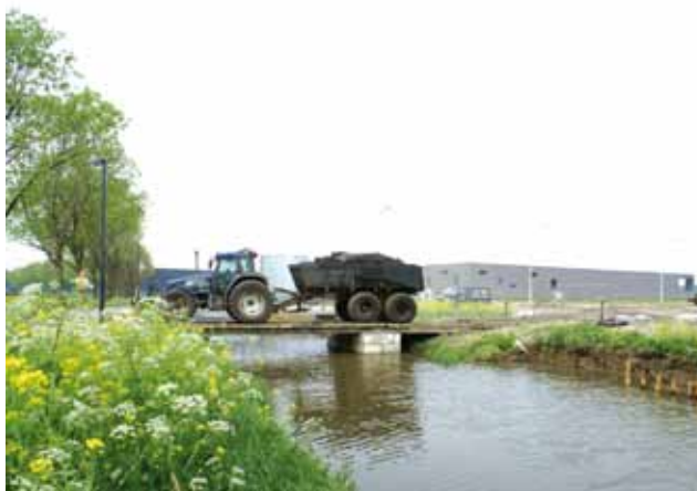
◀Gorinchem wil binnen de bebouwde kom geen trekkers op de openbare weg. Daarom werd in het bestek een brug opgenomen. Met betonnen legostenen en draglineschotten vond Hak een goedkope oplossing.
