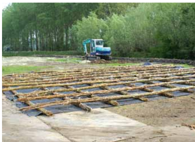
◀ De zinkstukken, in totaal 38.000 vierkante meter, zijn allemaal ter plaatse in elkaar gezet.
