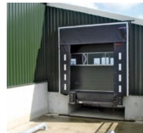
▲ Een laadkuil langs het gebouw is het gemakkelijkste in te passen.
