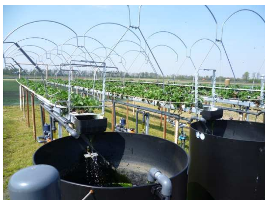
Foto 3. Een voorbeeld hoe water gerecicleerd kan worden op PPO vredepeel
