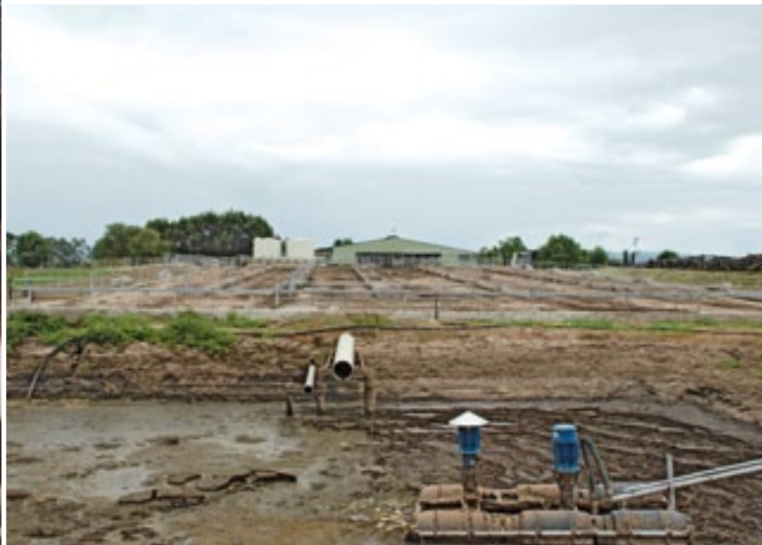
Met veel water uit een silo wordt mest van de betonnen voerplaats gespoeld en opgevangen.
