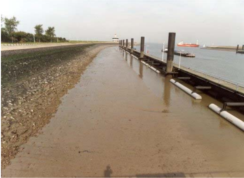
Afbeelding 18: Overzichtsfoto baggerwerkzaamheden achter remmingwerk
