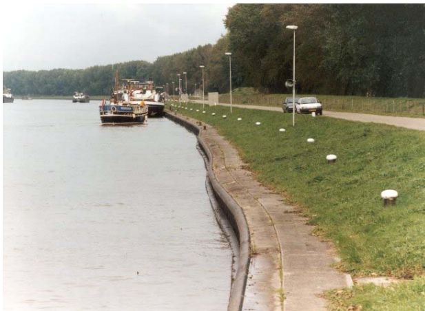
Afbeelding 8: Voorovergekomen damwand a.g.v. bezwaken anker
