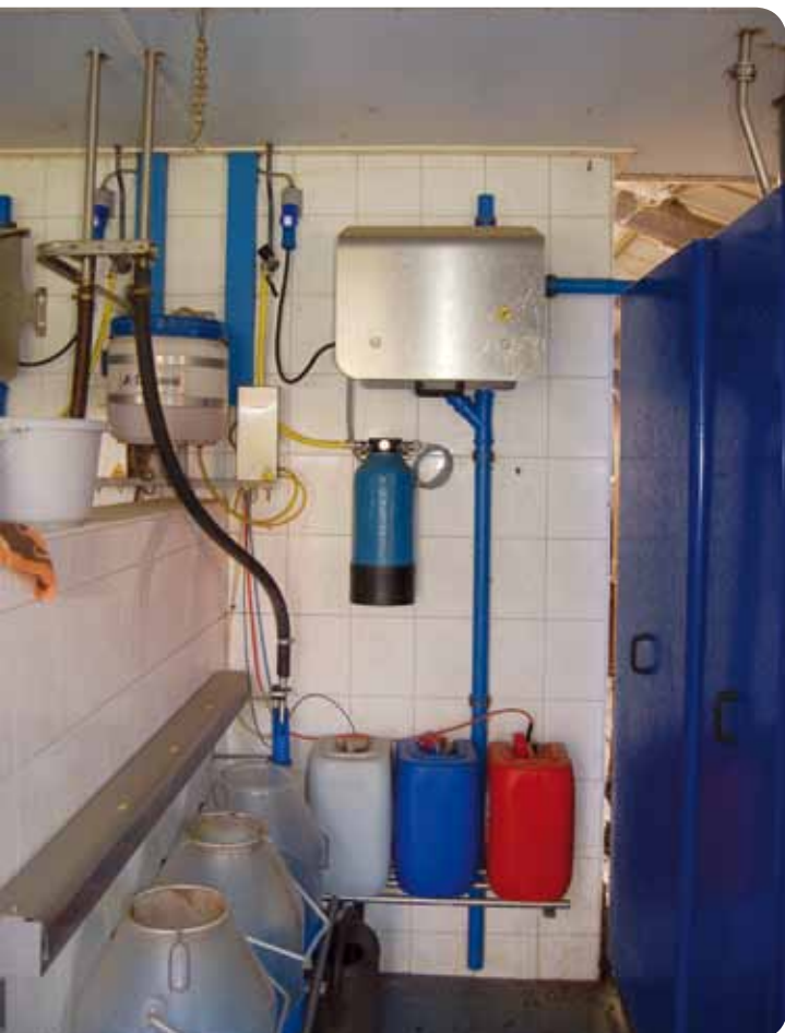
De stoomcleaner die Jalink vorig jaar liet installeren om te voorkomen dat koeien elkaar besmetten
