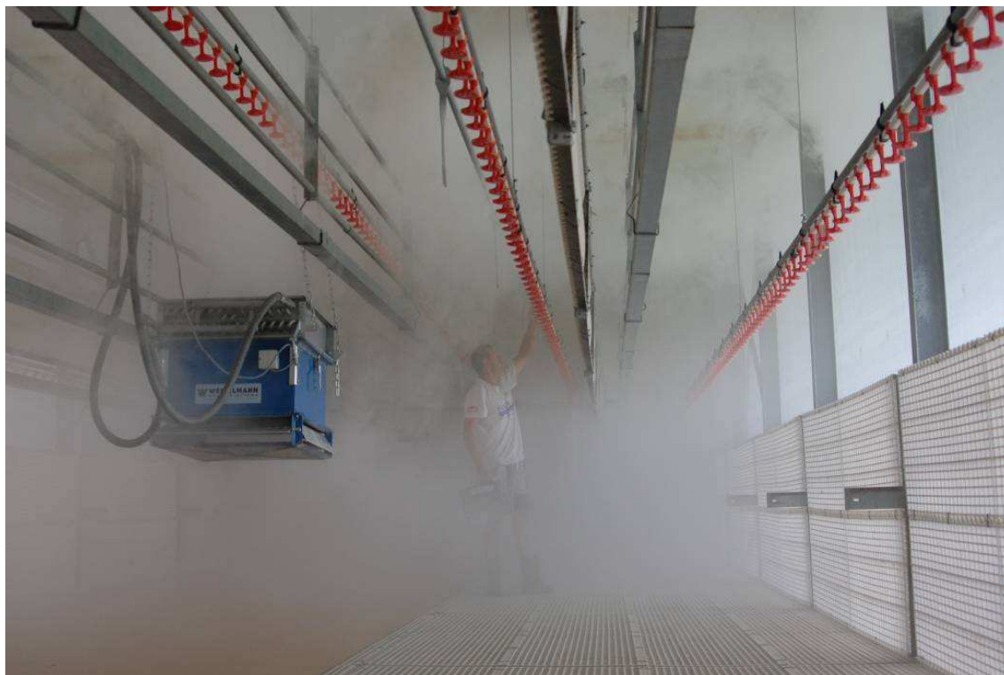
Foto 3 De verwarmde lucht verspreidt zich in alle richtingen door de stal. Dichtbij het verwarmingssysteem verspreidt de lucht zich snel, elders langzamer.
