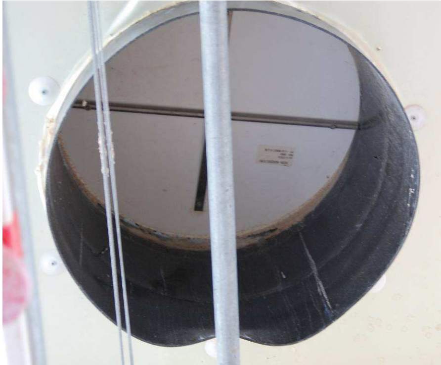
Figuur 1 Foto van het inlaatventiel
