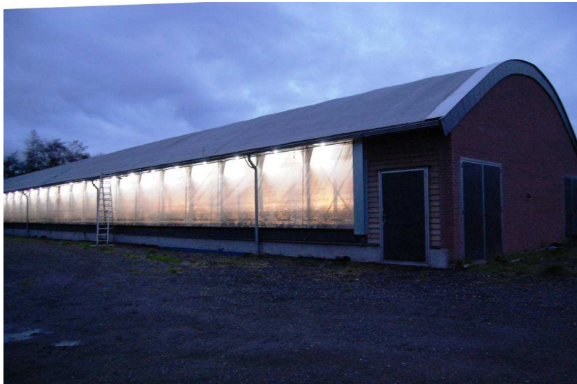
Figuur 2 Boogconstructie dak en transparante zeilen zuidwestzijde van de meetstal op de Lankerenhof
