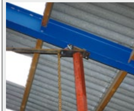
▲ Onder de plek waar de trekstang is vastgemaakt, komt de oliedrukvijsel.
