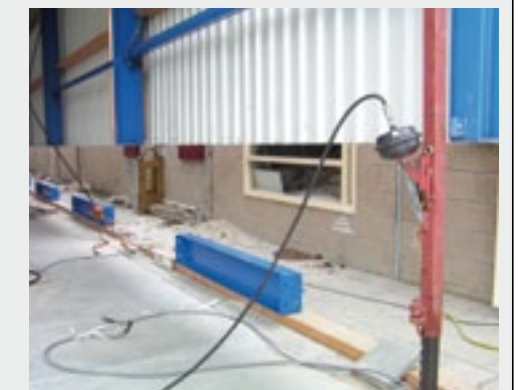
▲ Na het losmaken van de onderste damwandbeplating kon het liften beginnen.
