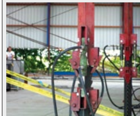
▲ Alle oliedrukvijsels zijn gekoppeld zodat ze met dezelfde snelheid omhooggaan.
