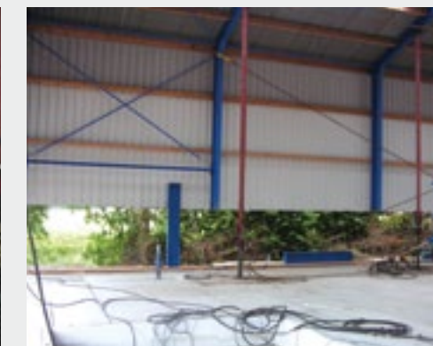
▲ Het liften gebeurde in twee keer; de slag van de vijsels was onvoldoende voor 2 meter.
