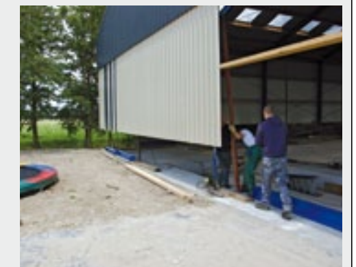
▲ Na het opvijzelen zijn de nieuwe stukken staal onder de standers gezet.
