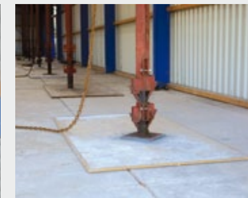
▲ Een plaat onder de oliedrukvijsel voorkomt olieplekken op de betonplaten.
