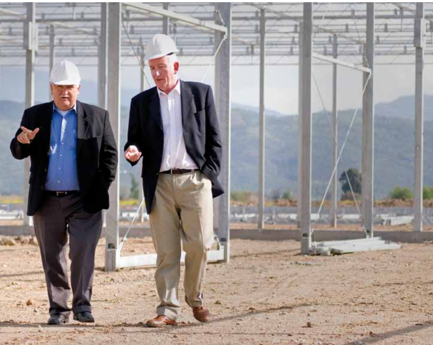
Ton Schrover en Ruud Maaswinkel in de demonstratiekas in aanbouw.
