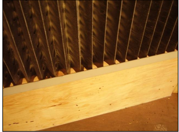
Detailfoto droogfilterwand uitgaande zijde
