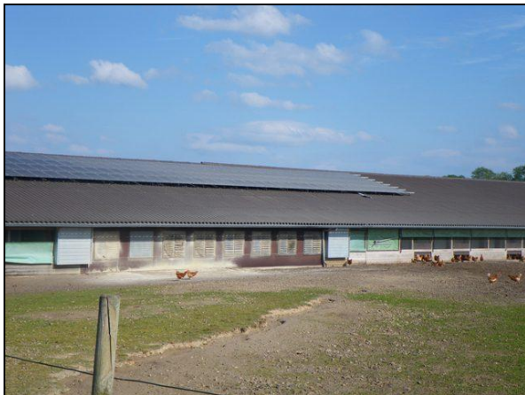
Ventilatoren halverwege de lengte van de stal
