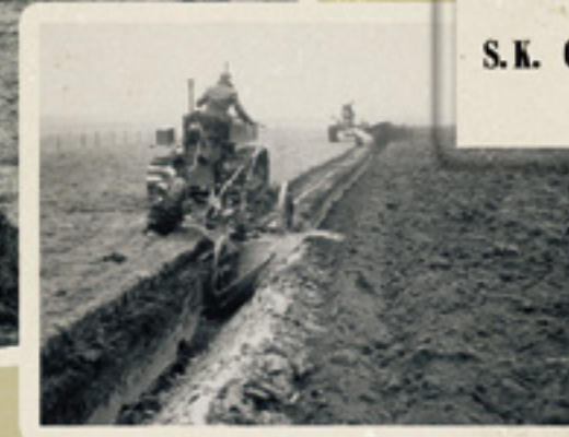
De frees achter de MAN trekker (foto links) werpt de laag met teelaarde die door het ploegrister is losgesneden over de omgewerkte ondergrond. De getrokken Melotte diepploeg (foto rechts) zit achter een 55 pk Hanomag rupstrekker.
