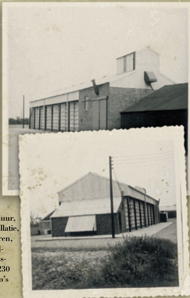
Een goed voorbeeld volgens de redactie van een in eigen beheer gebouwde Crittall-silo. Het afdakje op de voorgrond van de onderste foto dient voor regenwering en geluiddemping.
