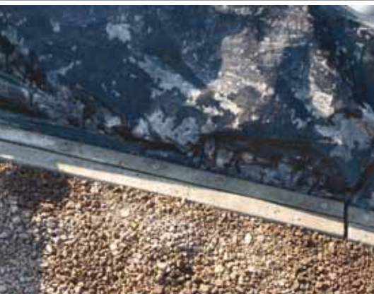
Worteldoek wordt aan de zijkant met een aluminium strip vastgezet aan de betonnen band.
