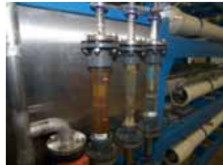
Figuur 4: Technieken voor mestverwerking zijn grotendeels beschikbaar.
