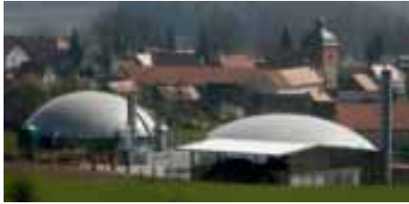
Figuur 6: Een biogasinstallatie met WKK voorziet het Duitse dorp Jühnde van warmte en stroom.
