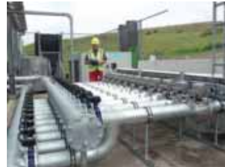
Figuur 8: Biogas uit huishoudelijk afval wordt opgewerkt tot groen gas en geïnjecteerd in het aardgasnet.
