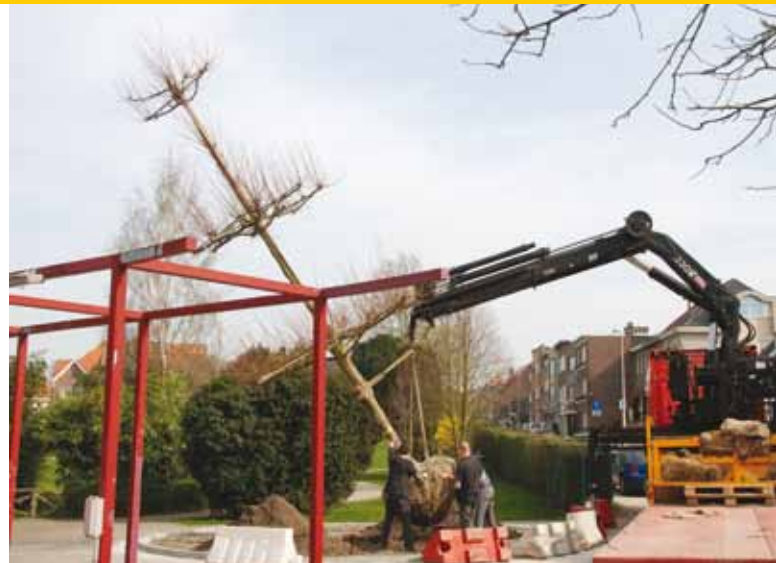
De boom wordt boven het plantgat gehesen.
