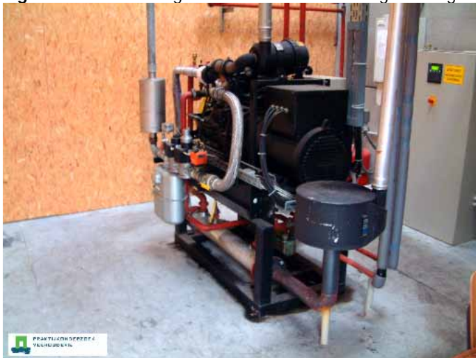
Figuur 4 Gasmotor geschikt voor de verbranding van biogas en de opwekking van elektriciteit en warmte
