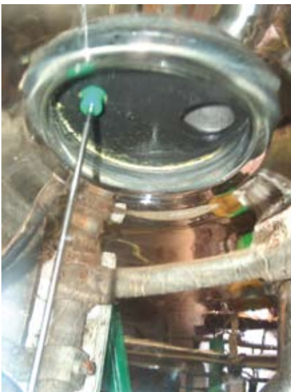
Bovenkant luchtafscheider is niet schoon.
