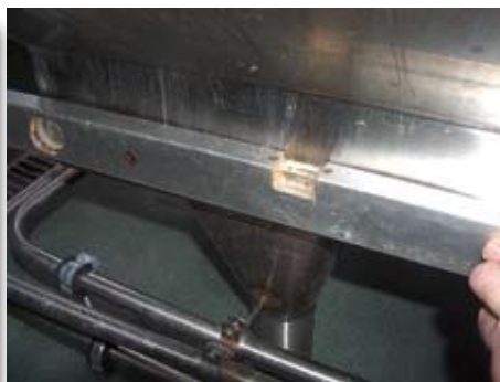
Controleer het afschot van de tank met een waterpas. In dit geval is het afschot meer dan 2%.
