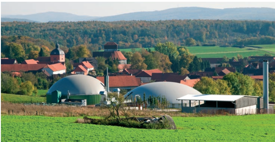
Een warmtekrachtcentrale op bioenergie (o.a. uit mest) in het Duitse Jühnde voorziet het hele dorp van warmte en stroom.
