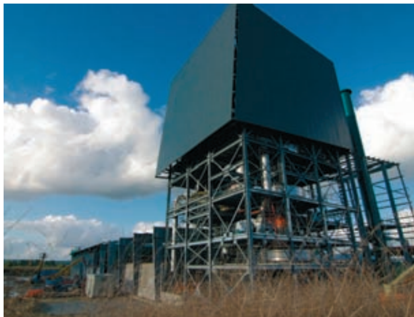
Uit laagwaardige houtreststromen ontstaat door torrefactie een hoogwaardige brandstof met hoge calorische waarde en goede verbrandingseigenschappen
