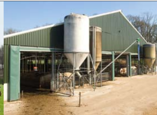
Door de open achterwand tocht het niet in de stal
