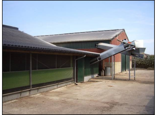
Schuur met droogtunnel haaks op achtergevel stal
