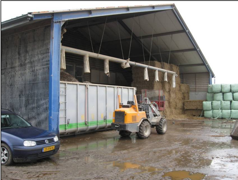
Achtergevel leghennenstal met droogtunnel onder het verlengde dak
