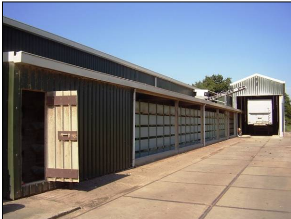
Droogtunnel (43,5 m) onder afdak met open front
