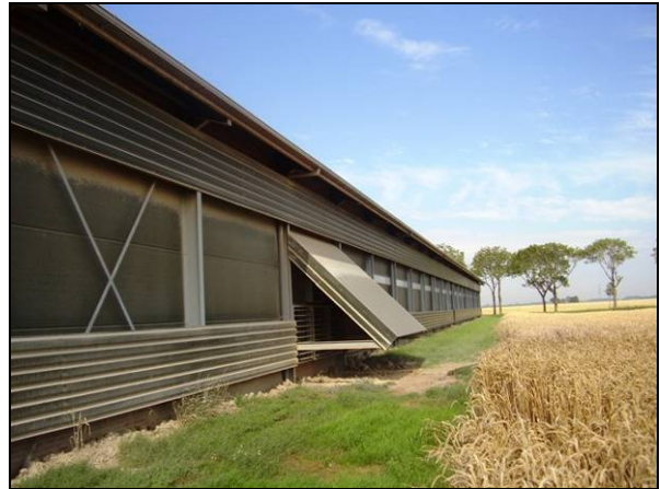
Groep van 4 bypassventilatoren (begane grond)
