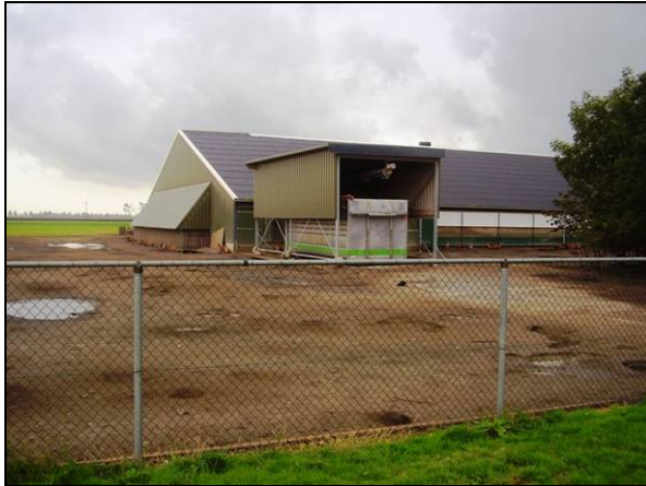
Achterzijde stal met in pandige droogtunnel en container
