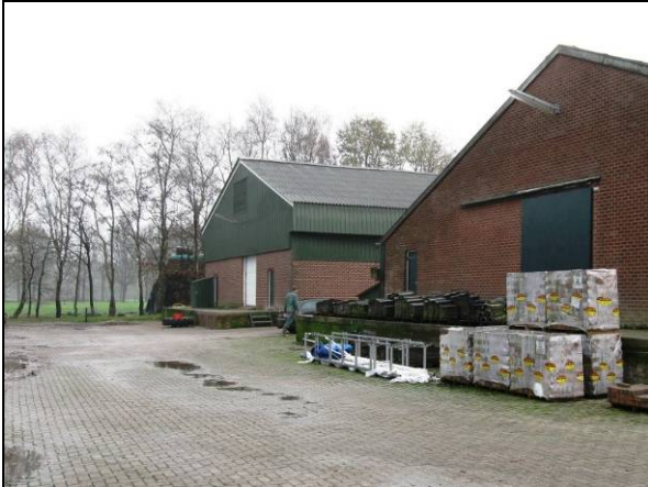
Achtergevels stallen (links stal 1, rechts stal 2)
