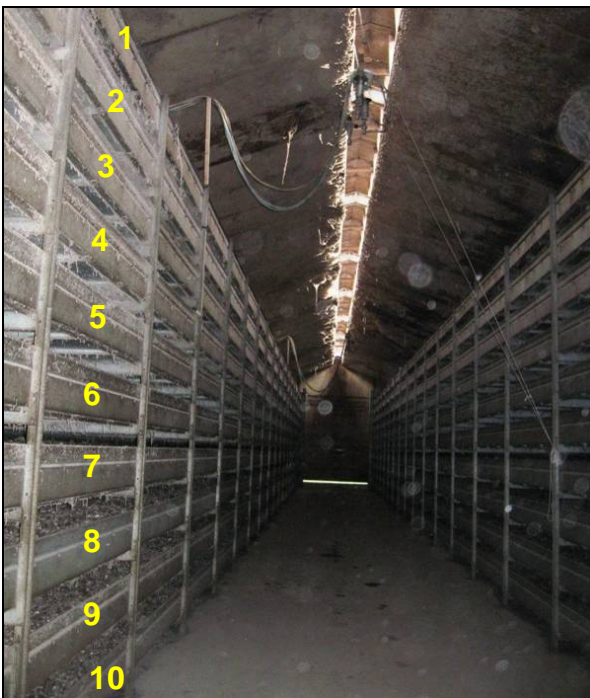
Meting uitgaande lucht, nok, binnenzijde tunnel De banden zijn genummerd van vers naar droog
