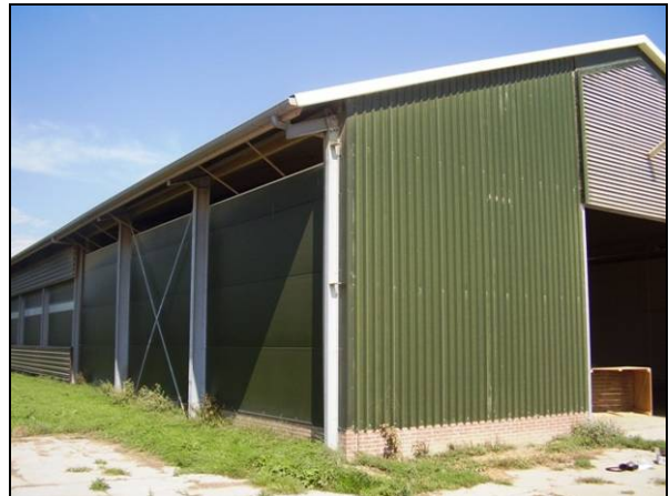
Luchtuitlaat: open strook in zijgevel en achterdeur
