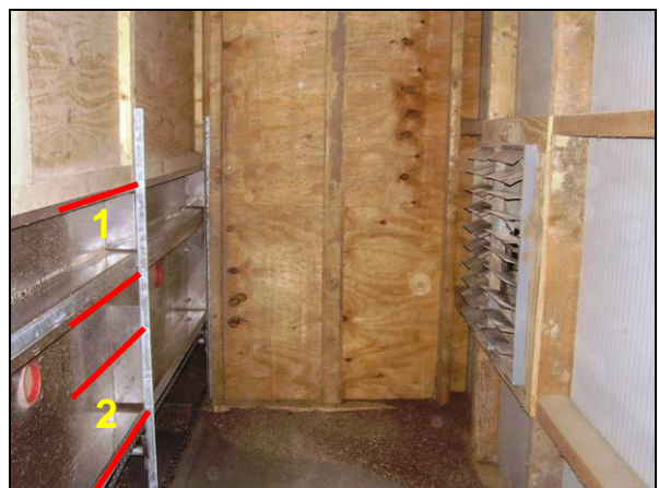
Drukkamer tussen achtergevel stal en droogtunnel De posities van de mestbanden zijn genummerd Lucht stroomt door laag 2 en 1 omhoog naar buiten
