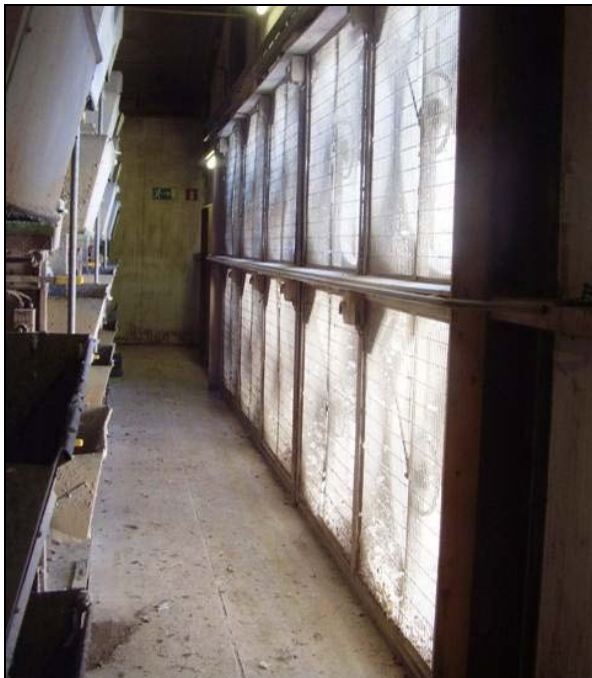
Groep van 10 bypassventilatoren in achtergevel
