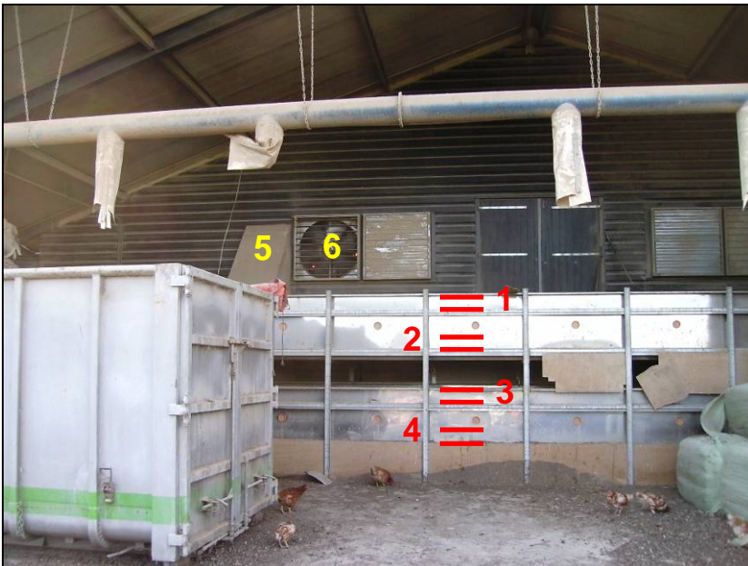
Detailfoto van de droogtunnel langsij de achtergevel onder het verlengde dak
