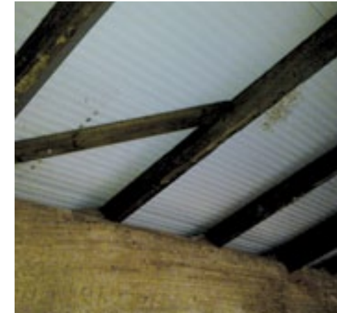
▲ Deze gordingen waren nog goed genoeg om het nieuwe geïsoleerde dak te dragen.
