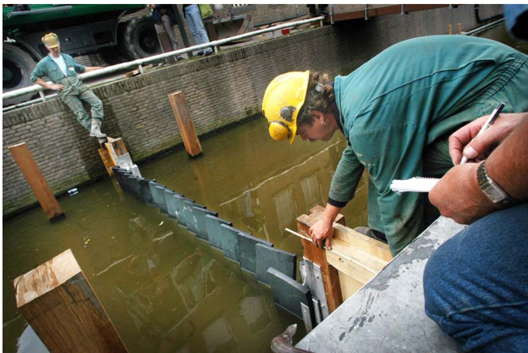
Figuur 9 Installatie van een doorvaarbare waterkering in de stadsgrachten van Leeuwarden.
