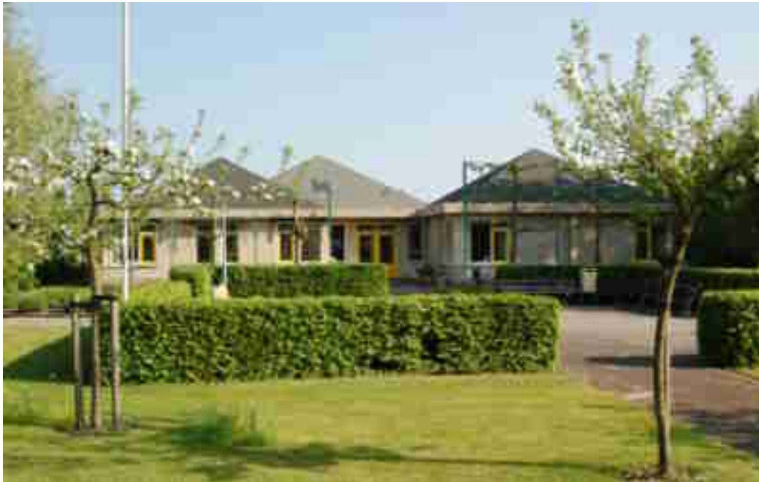
Het gebouw van het CBL aan de Bronsweg 's zomers en 's winters.
