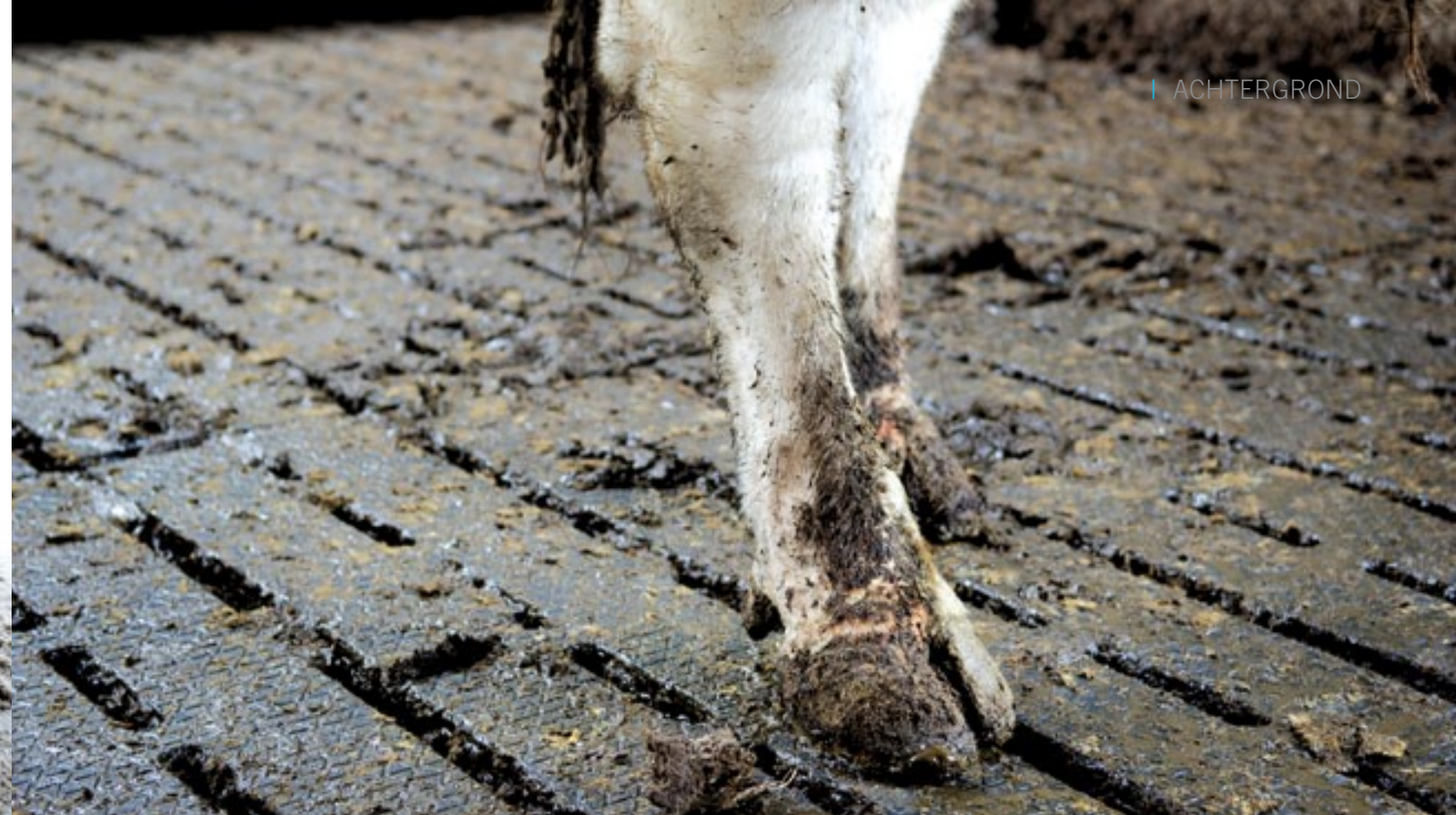
Op de vloer van het stierenhek moet een zacht materiaal liggen. Beton is te hard voor de zware dieren. Rubber voldoet goed.
