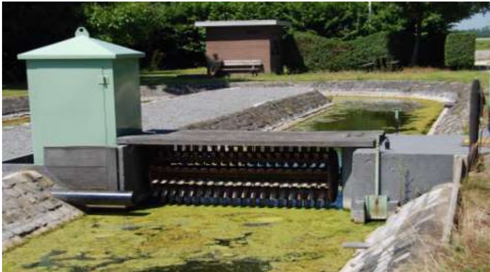
Figuur 4 Pasveersloot voor biologische zuivering van huishoudelijk afvalwater. Het schoepenwiel zorgt voor zuurstofinbreng en een rondgaande beweging van het afvalwater. De Pasveersloot was een voorloper van de huidige rioolwaterzuiveringen met bellenbeluchting.
