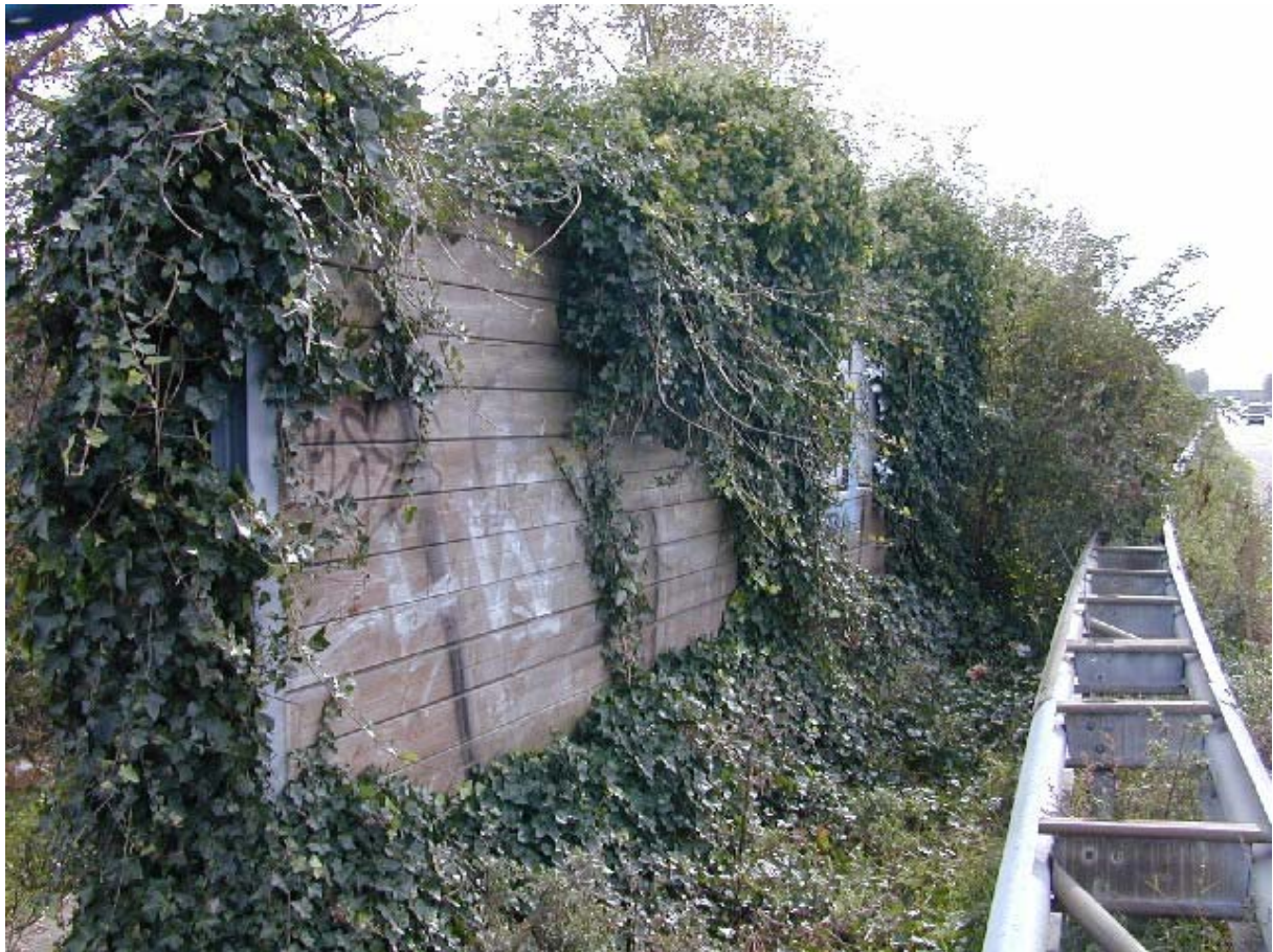
Afbeelding 5: Rijke groei van de klimop aan de achterzijde veroorzaakt grote overhangende bossen op de bovenrand van het scherm. Foto PPO
