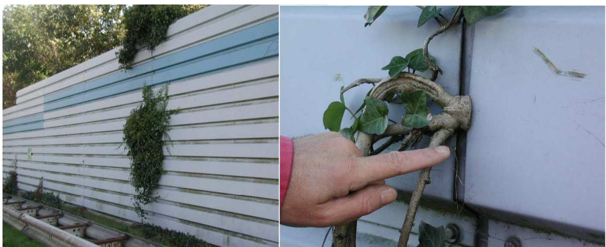
Afbeelding 7: Wilde wingerd ziet wel kans om het scherm te begroeien, maar ook deze soort blijft vooral in het horizontale profiel "hangen". Foto RWS
