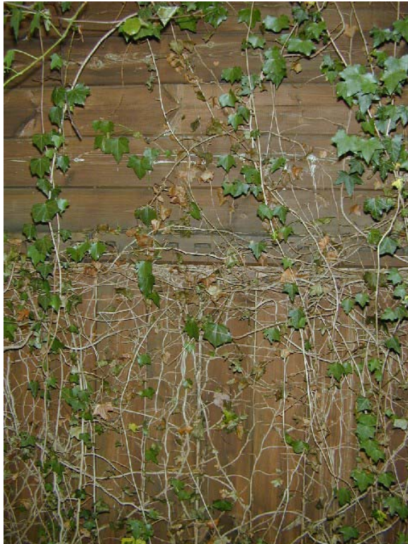
Afbeelding 13: Detail van het scherm met duidelijk zichtbaar het verschil in begroeiing van het deel met horizontale planken (boven) en dat met verticale planken (onder). (foto: PPO)
