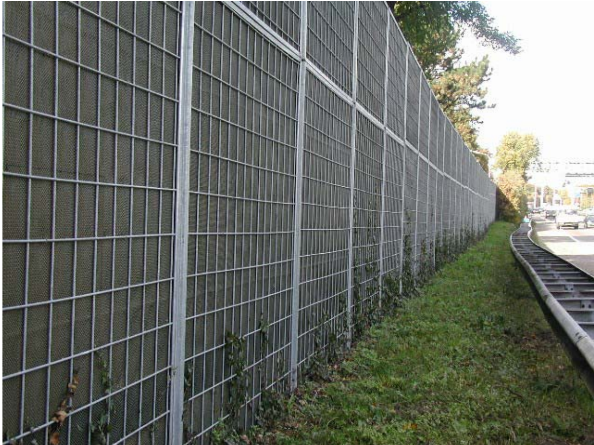
Afbeelding 9: Rockdelta scherm langs A1 bij Laren. Foto RWS
