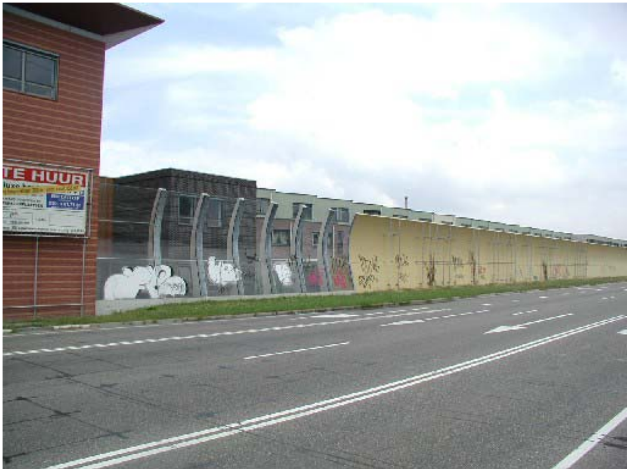
Afbeelding 19 Gebogen scherm langs de N470 bij Delft. Foto RWS
