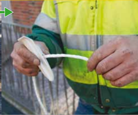
Stap 2: Je haalt het touw (Natu-rope) door het ankertje (Natu-keeper)
