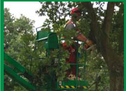
Snoeien van een laanboom met een hoogwerker
