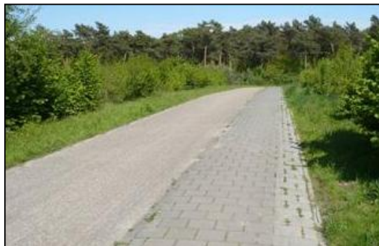
Foto 11 Beboste groenstroken op viaduct Gentiaan over rijksweg A50 nabij Son en Breugel.
