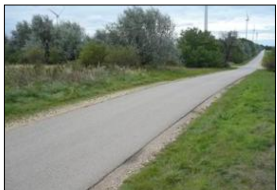
Foto 23 Op het ecoduct over de E60 in Oostenrijk is een asfaltweg aangelegd voor lokaal verkeer.
