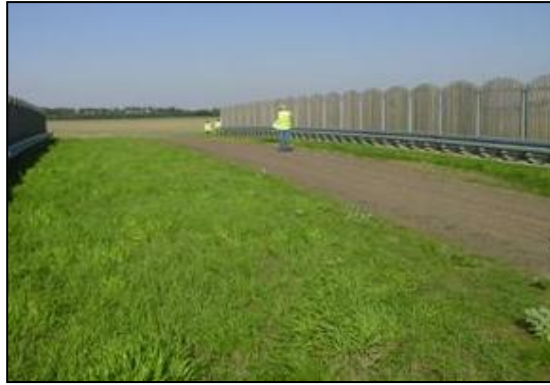
Foto 25 Op het ecoduct over de A2 in Polen is naast graslandvegetaties een onverharde landbouwweg aangelegd.
