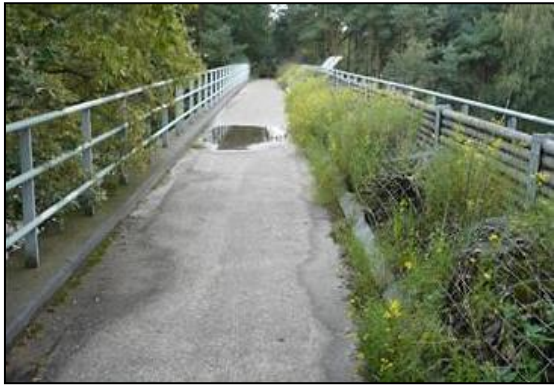
Foto 14 Groenstrook op viaduct Leenderheide over rijksweg A67 nabij Eindhoven
