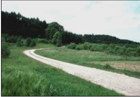
Foto 18 Halfverharde bosweg op ecoduct Hirschweg over rijksweg B31 in zuidoost-Duitsland.
