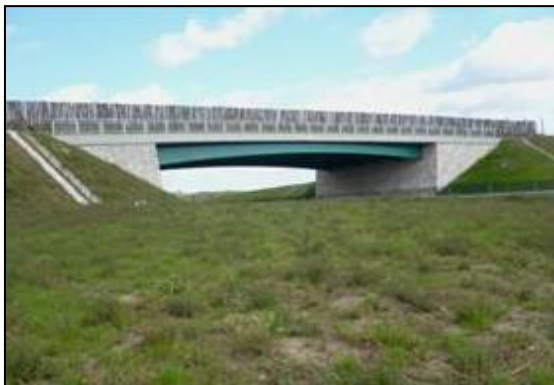
Foto 20 Ecoduct over rijksweg M6 in Hongarije.
