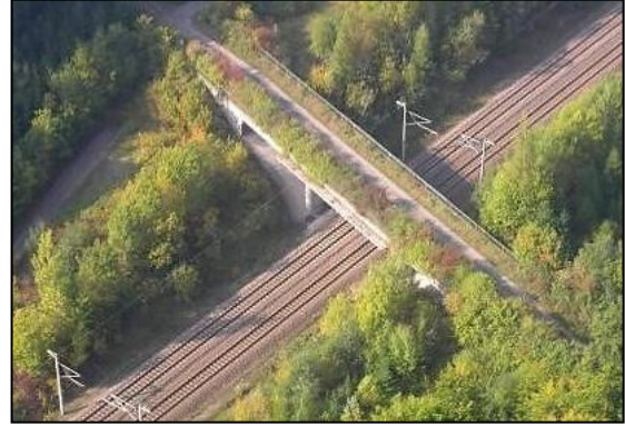
Foto 19 Groenstroken aan weerszijden van een halfverharde bosweg op viaduct Oberderdingen over de spoorlijn Stuttgart-Mannheim in zuidoost-Duitsland. Foto: B. Georgii
