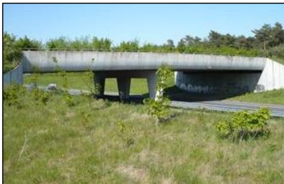
Foto 10 Aanzicht viaduct Gentiaan over rijksweg A50 nabij Son en Breugel.
