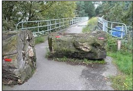
Foto 15 Viaduct Leenderheide is ontoegankelijk gemaakt voor gemotoriseerd verkeer.
